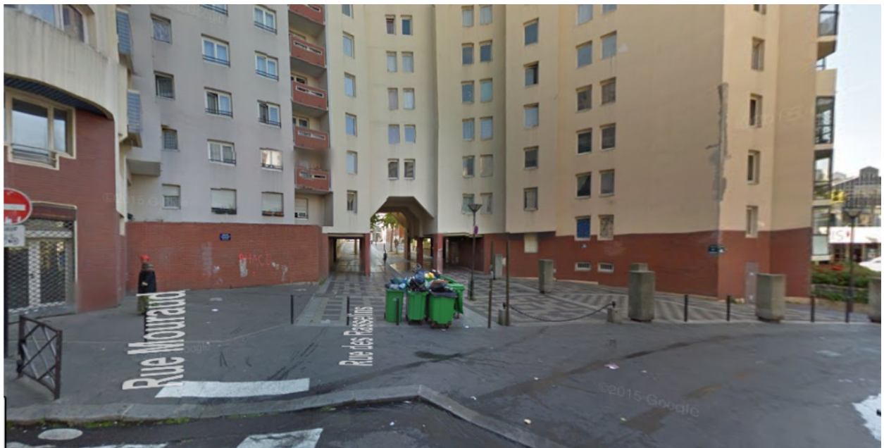
Rue des Rasselinsl, Paris
